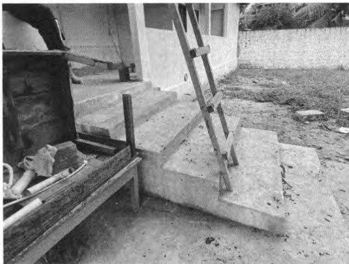
Detalhe da escada que dá acesso ao fundo do terreno, mostrando o desnível e confirmando a necessidade de aterro da área construída.
