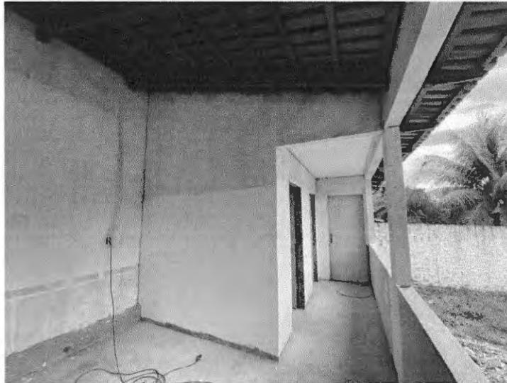
Vista interna do pátio coberto com detalhe para o piso feito que receberá o revestimento cerâmico.
