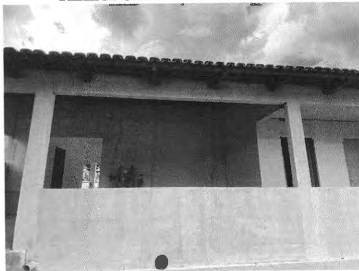
Construção dos novos banheiros e depósito (vista posterior), com detalhes para serviços de estrutura em concreto, paredes e cobertura em trama de madeira e telhamento cerâmico.
