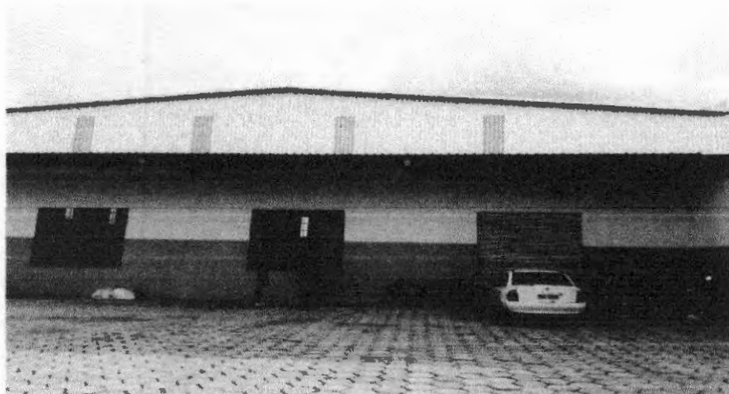
Imagem 01: Fachada Frontal do Galpão Comercial.
