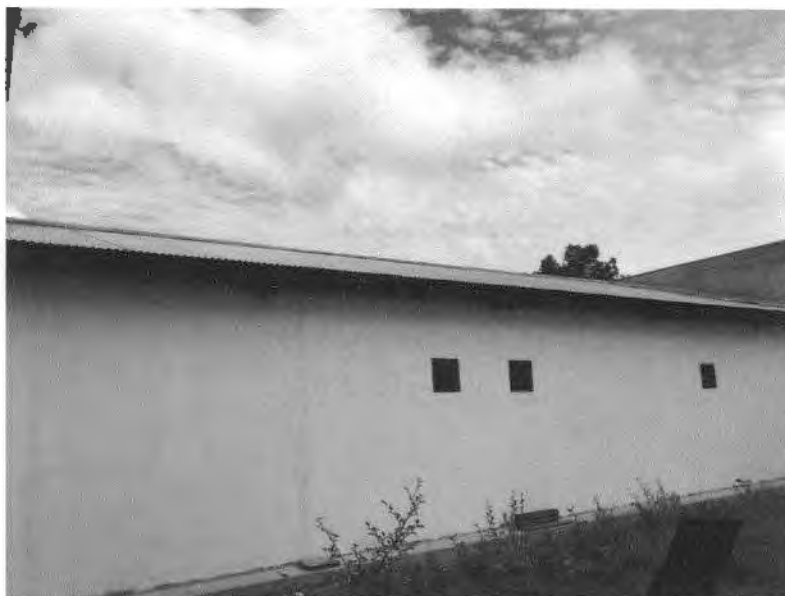
Fachada lateral da edificação com vistas para a cobertura metálica executada
