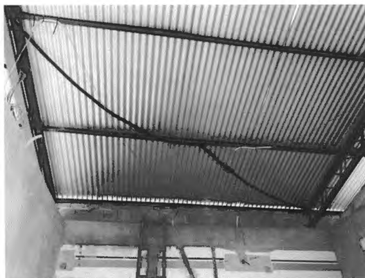
Colocação de terças e treliças metálicas
