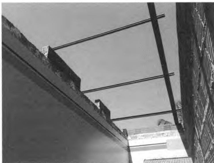
Colocação de terças metálicas
