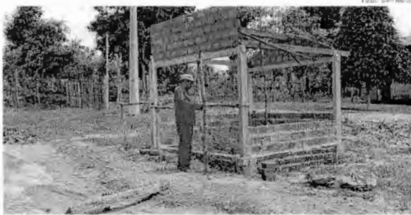
Parada de ônibus está sendo construída com recursos dos moradores do Quebra-Pote para conforto da população
