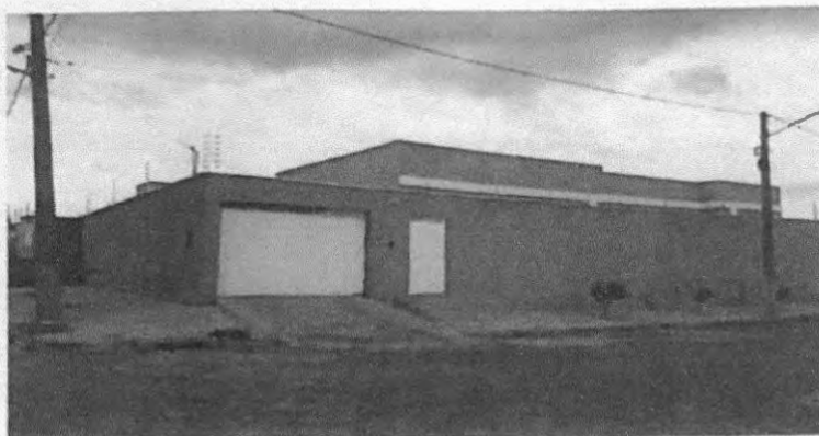
Imagem 01: Fachada Frontal da obra
