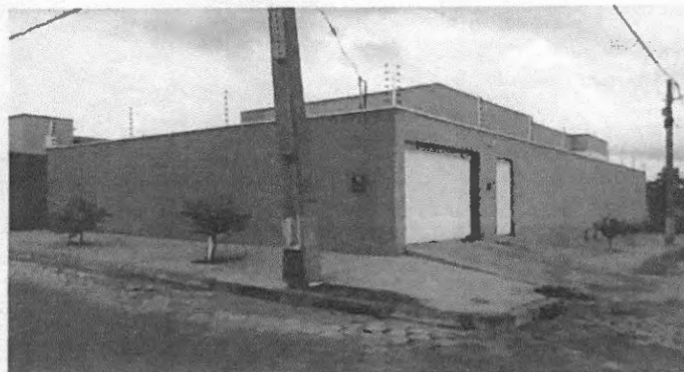
Imagem 02: Fachada Frontal e Lateral da obra
