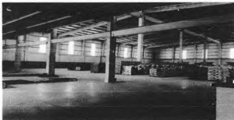
Imagem 04: Galpão parte interna da construção.
