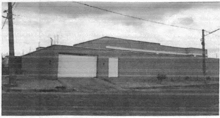
Imagem 01: Fachada Frontal da obra
