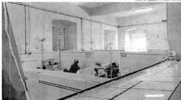
Paredes com mofo e descascadas: ambiente insalubre para mais de 50 pacientes, que ocupam uma das alas
